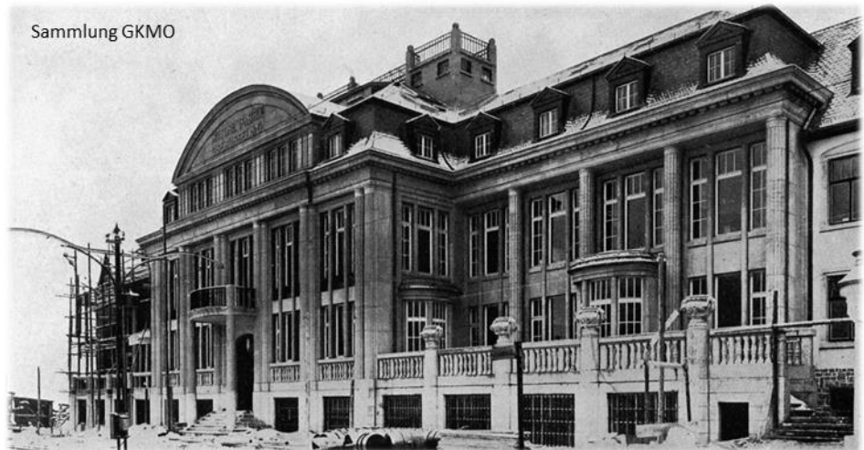
Das neue Verwaltungsgebäudes im Winter 1917/1918 - Mittelbau und rechter Seitenflügel sind fertiggestellt, der linke Seitenflügel steht noch im Endausbau
